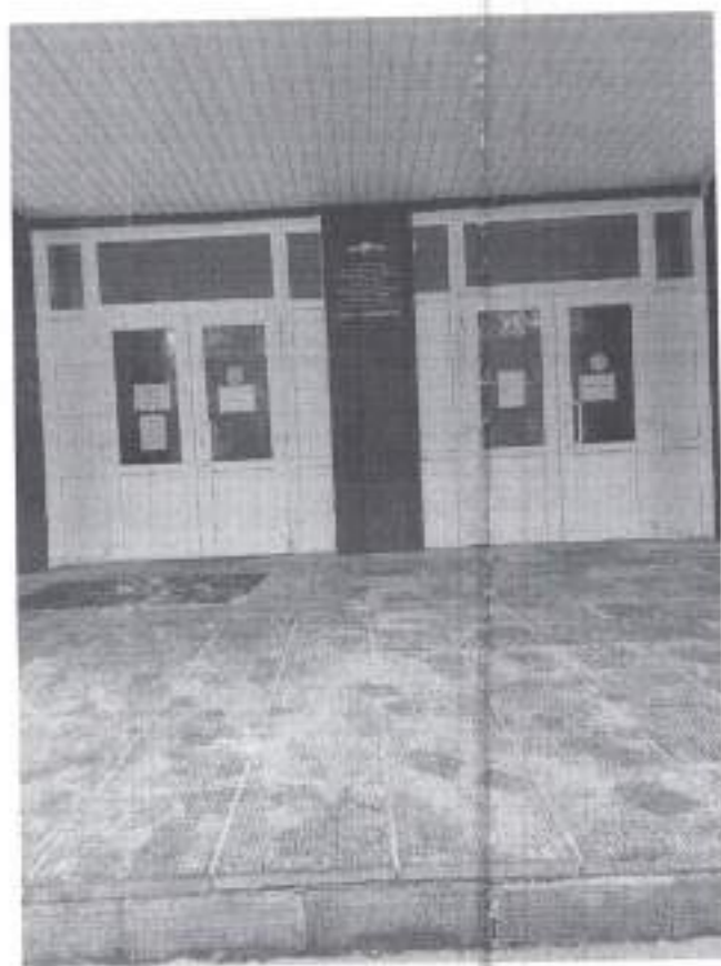
Фото.№ 7 Входная площадка (перед дверью)
