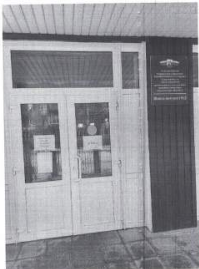
Фото № 8 Дверь (входная)
