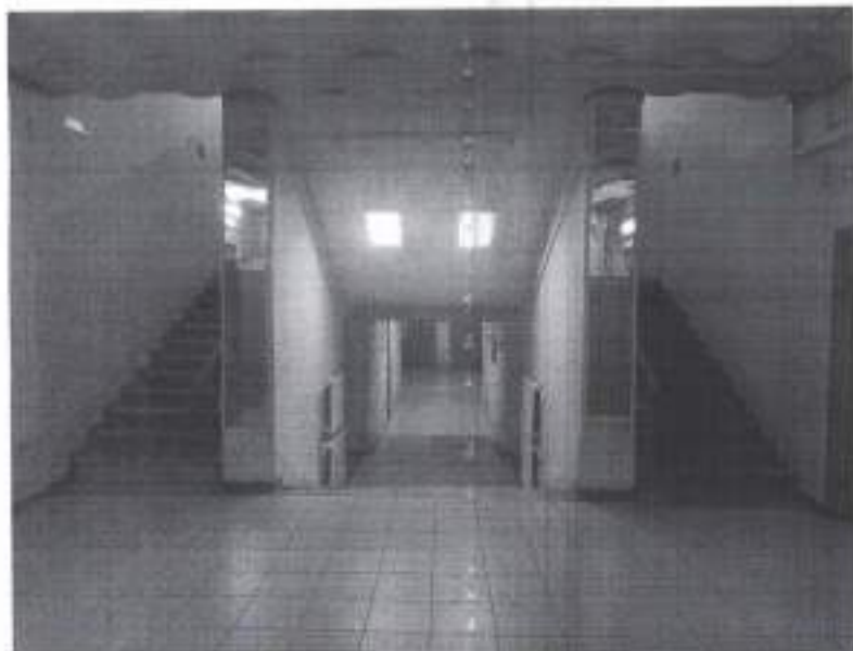
Фото 10 Лестница (внутри здания)
