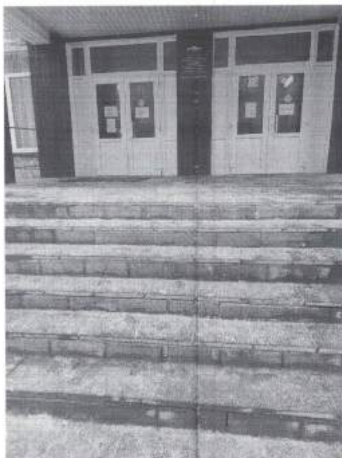
Фото.№ 5 Лестница (наружная)
