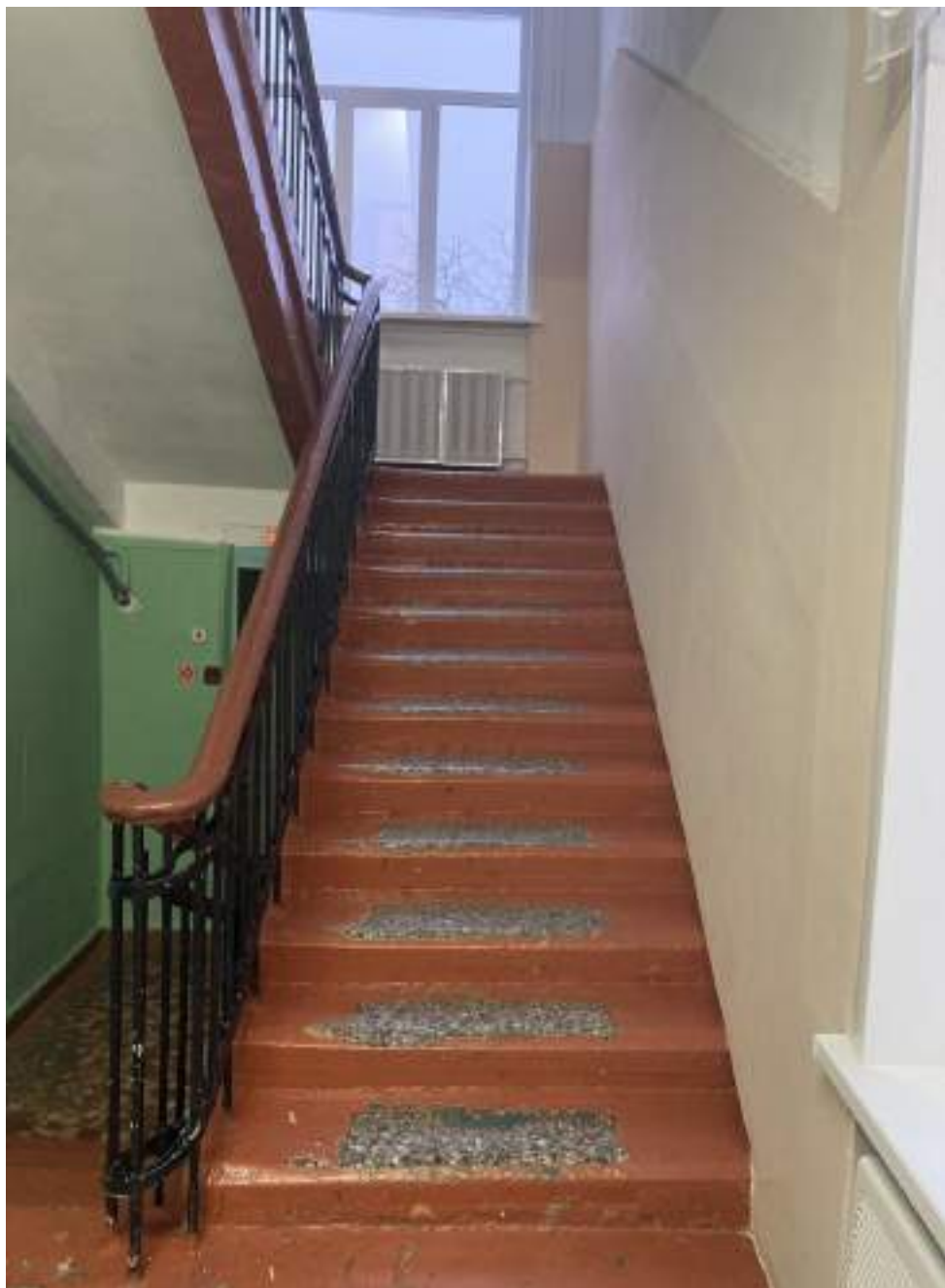
Фото №11 Лестница (внутри здания)
