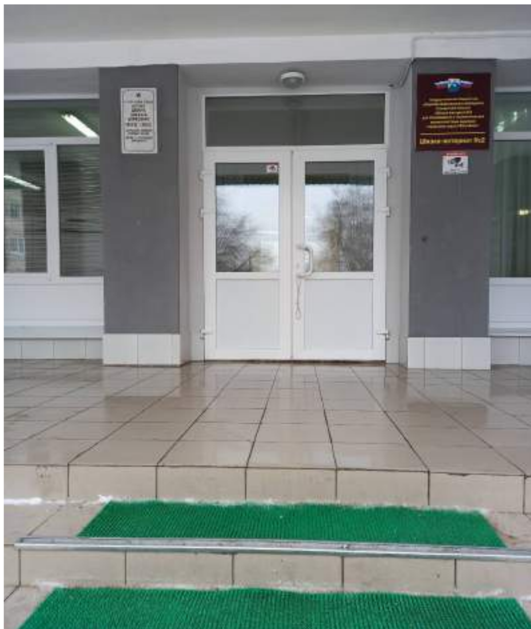
Фото №5 Входная площадка (перед дверью)
