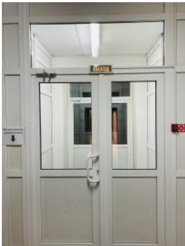
Фото №20 Визуальные средства путей эвакуации
