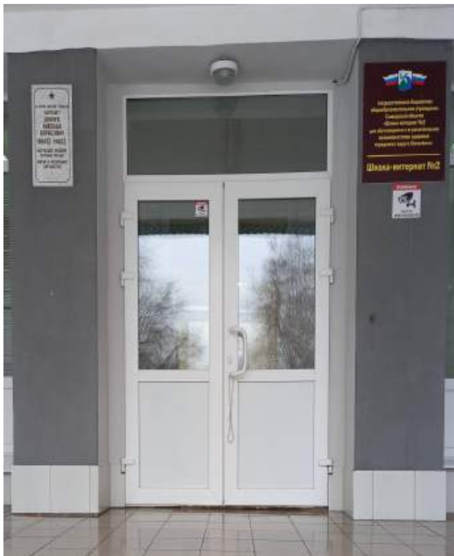
Фото №6 Дверь входная
