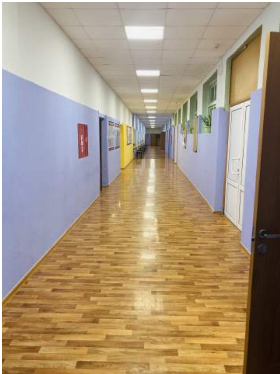
Фото №15 Пути эвакуации
